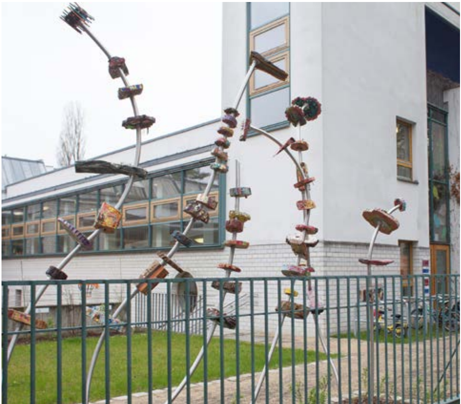
Neubau der Kita
